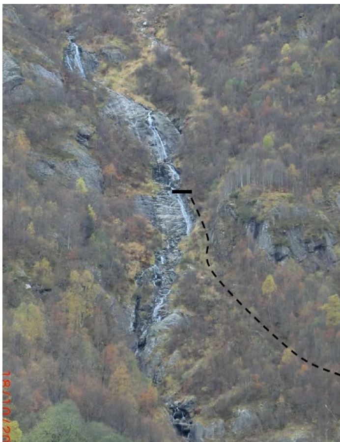
Botnagrovi 18.10.2013. Inntak og litt av rørgata er vist.
