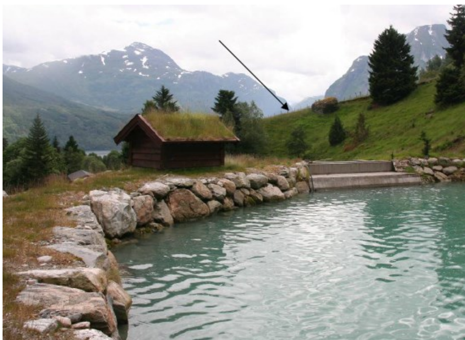
Avløpskulverten frå kraftstasjonen (pil) skal gravast ned i lia bort til inntaksbassenget til Neselva I
